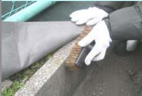
接着面の砂埃を除去します。雨天時など接着面が濡れている場合は乾燥後、お使い下さい。
