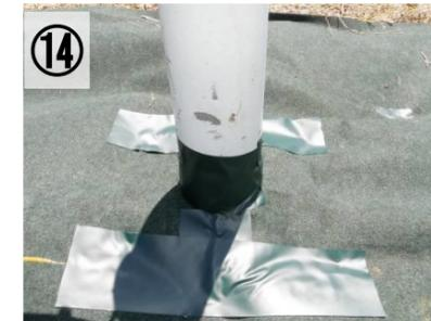
**⑭** 粘着テープを支柱カバーのシート端部にそれぞれ貼る。テープの中央とシート端部を合わせると重ね部分の収まりが良い。
