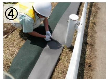
**④** 支柱位置で、折り曲げたシートの端部から支柱の中心に向けて、切込みを入れる。
