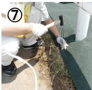
**⑦** 切り込み部分の端を止めピンで固定し、その後シート全体を止めピンで固定する。
