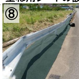
**⑧** シートの切り込みを入れた側に重ね用のシートを貼る。重ね用のシートは、ガードレールと道路端部までの距離に応じて予めカットしておく。また、シート、道路への重ね幅は10cm以上とする。
