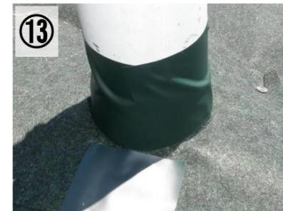
**⑬** 支柱カバーのフチ部分を粘着テープを50cm程度にカットしたもので、支柱に巻き付けるようにして貼る。
