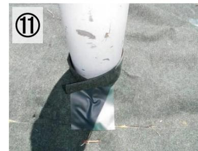
**⑪** 支柱カバーをガードレール支柱にセットし、切れ目部分に粘着テープを10cm程度にカットしたものを貼る。
