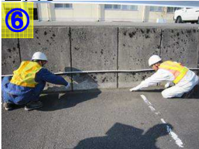
抜根除草・目地堆積物の処理
