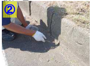
抜根除草・目地堆積物の処理
