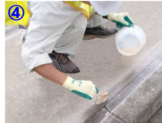
ハケなどを用いてプライマーを均一に塗布する。(塗布の目安: 27ml/m)
