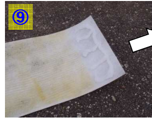
50mm以上重ね、アタッチを進行方向に5列塗り、端部からおよそ5mm内側にシーリングする。貼り付け後、ゴムハンマーで圧着する。
