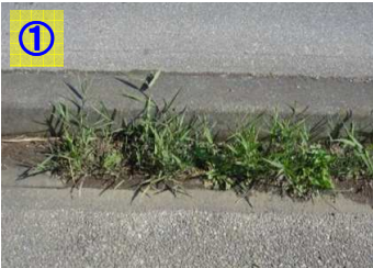
施工前の状態
