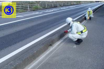
ラインチョークなどでプライマー塗布の位置出しを行う。(幅15cm)
