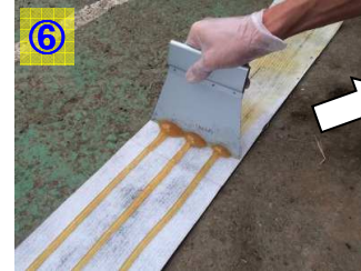
ウレタッチをシート裏面全体に均一になるよう塗布する。ウレタッチのノズルは先端から二番目で切る。(塗布の目安: 100ml/m: シート1本(5m)当りウレタッチ1本使用)
