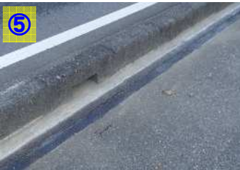
プライマーの溶剤が揮発し乾燥するまで、夏期は10分以上、冬期は20分以上、養生を行う。
