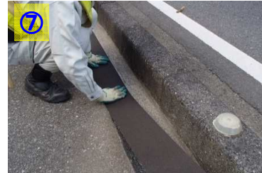
舗装部の劣化が激しい箇所はシートを2列で貼り付けて施工する。シート上に重なる部分はアタッチで接着する。(重ね: 5cm以上)
