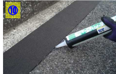
路面の凹凸が大きい場合は、アタッチでシーリング処理する。
