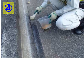
ハケなどを用いてプライマーPU1-5Kを均一に塗布する。(塗布の目安: 60g/m)
