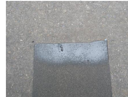
重ね部分の加熱処理
