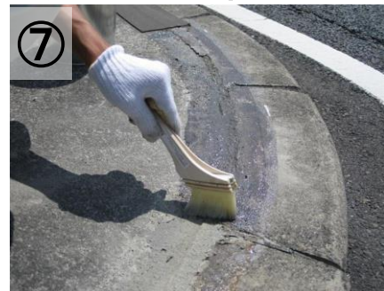
プライマー塗布
