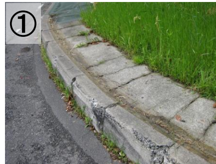
施工前の状態
