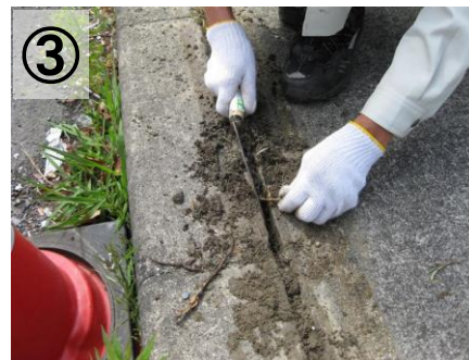
抜根除草・目地堆積物の処理
