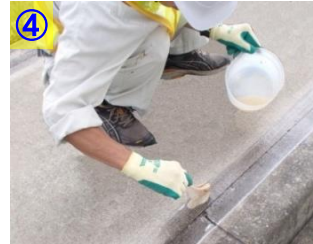
ハケなどを用いてプライマーPR1を均一に塗布する。(塗布の目安: 34ml/m)
