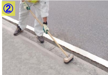
ワイヤーブラシなどを用い、路面の土埃などの除去を行う。
