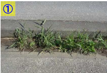
施工前の状態
