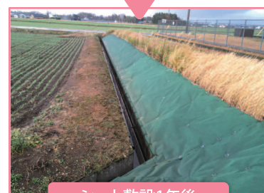
シート敷設1年後
