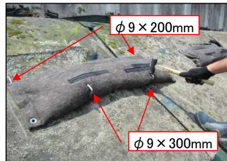
⑥ファスナーを開けて手で土を押し広げて植え穴を作り、ポット苗を挿入して隙間の無いように土を戻し、密着するように、しっかり押さえファスナーを閉める。
