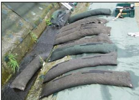
⑤チューブ土嚢を設置場所へ置き止めピンで固定する。
