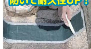
シールの端部を保護することで、泥上げの際のスコップや流れてくる土砂によるシール剥がれを防ぎます
