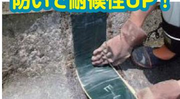
シーリング材が紫外線で劣化しないよう、耐候性のあるシールを上から貼って保護します。
