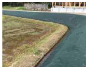
〈施工後〉 田園によくなじむ色合い
