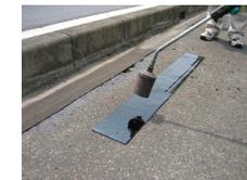
5. 必要な長さにカットした目地バリシートの裏面を、バーナーで加熱する。
