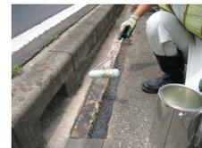
4. プライマーPR1-5L/15Lの塗布塗布後、十分に時間を置き、完全に乾燥させる。
