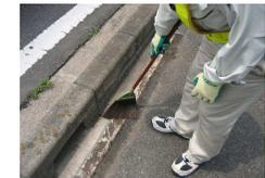
3. 路面の清掃 (接着不良の要因となる砂埃の除去)
