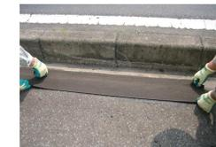
6. 加熱後、路面に貼り付け、特に端部を十分に転圧する。
