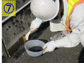
⑦ 施工面の砂埃を払い、刷毛などを用いてプライマーPU1-5Kを均一に塗布する。
