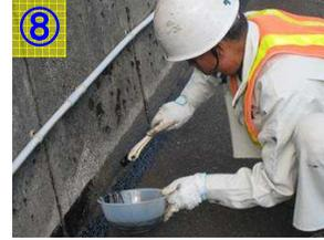
⑧ プライマーが乾いたことを確認後、接着剤GUI-12Kを塗る。不陸を埋めるように塗りこみ、ムラが出ないように薄く塗り広げて塗布する。
