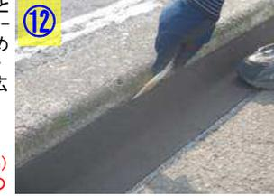
⑫ 貼り付け作業からおよそ10~20分後に、接着剤の接着力が強くなっているかを確認し、弱いところは再度圧着または、接着剤を追加塗布する。
