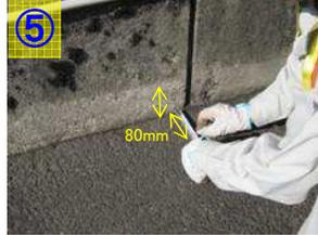
⑤ 貼り付け位置(路面および壁面ともに80mm幅)をスケールで測定し、数箇所チョークでマーキングする。
