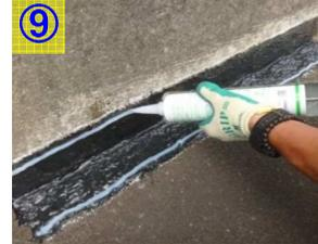
⑨ 路面および壁面ともに墨出し位置から10mm内側にアタッチをシーリングする。
