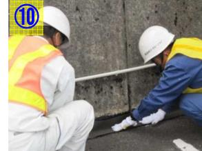
⑩ シートを中央の溝に沿って折り曲げ、L型部分へフィットするように貼り付け、シートが浮かないように手で圧着を行う。
