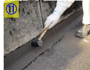
⑪ ゴム製ハンマーでシートを均一に叩いて圧着させる。端部から接着剤、アタッチが多くなればみ出した場合はヘラなどでかきとる。
