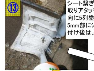
⑬ シート繋ぎ部はオーバーラップ50mmを取りアタッチで接着させる。進行方向に5列塗り、切り取り面は端から5mm部にシーリングして貼付する。貼り付け後は、ゴムハンマーで圧着する。
