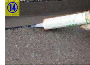
⑭ 下地路面の凹凸が大きい場合は、アタッチでシーリング処理する。
