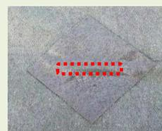
ピン頭部にたけガードテープ(□10cm)を貼り付ける際は、ピン頭部がテープの対角線上にくるよう、貼り付け位置調整して下さい
