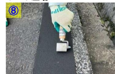
ローラーでシートを圧着し、Dタッチが均等にひろがるようにシート全体に馴染ませる。
