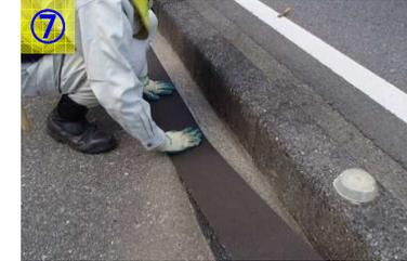
強草目地シートを拵げ、位置を合わせながら貼り付けていく。※舗装部の劣化が激しい場合は重ね貼りを行う。(2頁目参照)
