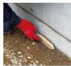
STEP 5 プリベントシートをアンカーピンで固定します。
