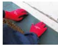
STEP 8 プリベントシートに接続する防草シートは10cm以上の重ねを設けて設置して下さい。
