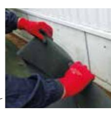
STEP 7 シーリングした部分をへらなどで押し広げ十分な量で隙間なく埋めて下さい。
