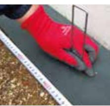
STEP 2 アンカーピンや釘などを使用して、設置する際(きわ)を3cm以上スジ掘りします。
