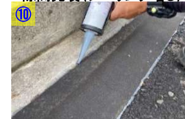
シートと舗装面に隙間がある場合は、Dタッチで隙間充填する。
