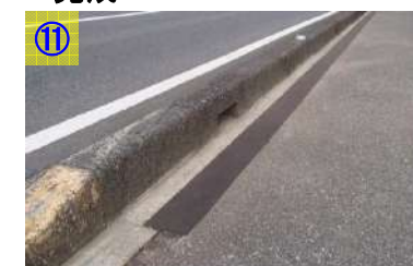
点検し、問題がなければ完成。
