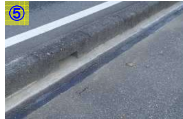
プライマーの溶剤が揮発し乾燥するまで、夏期は10分以上、冬期は20分以上、養生を行う。
