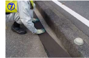
強草目地シートを上げ、位置を合わせながら貼り付けていく。 ※舗装部の劣化が激しい場合は重ね貼りを行う。(2頁目参照)
