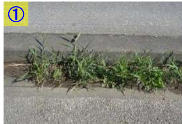
施工前の状態
