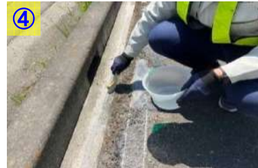
ハケを用いてシールプライマー#1を均一に塗布する。(塗布の目安:40g/m)
